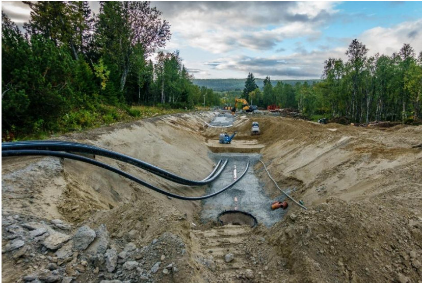
Bild tagen 2026-09-06. Återuppbyggnad av vägkropp pågår. Här ses bland annat de nedgrävda ledningarna/rören för vatten och avlopp. Samt de olika fraktionerna som bygger upp den nya vägkroppen. Foto: Börjes Kalle Skarefjäll.
