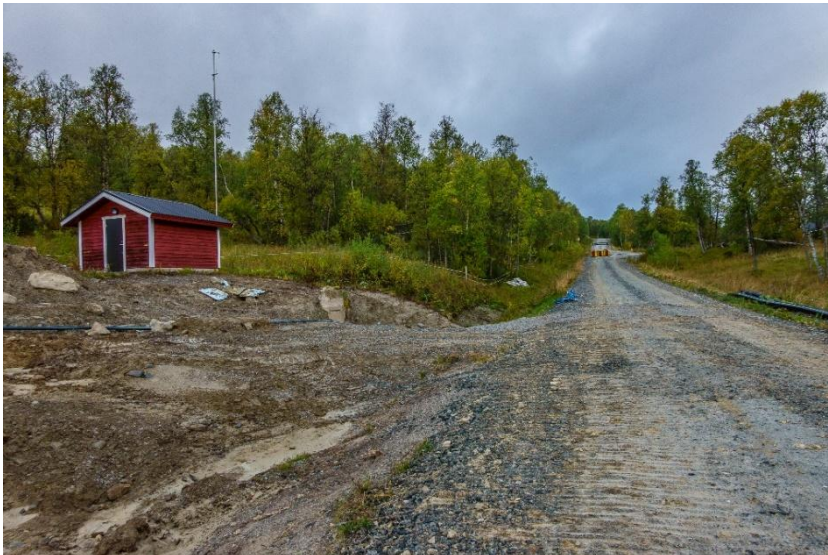
Bild tagen 2026-09-06. Den gamla pumpstationen i den norra delen av delsträcka 3. Foto: Börjes Kalle Skarefjäll.
