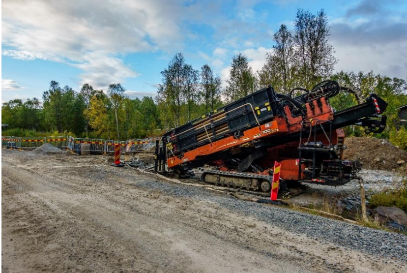
Bild tagen 2026-09-06. Pågående styrd borrhning norr om Össjan. Foto: Börjes Kalle Skarefjäll.
