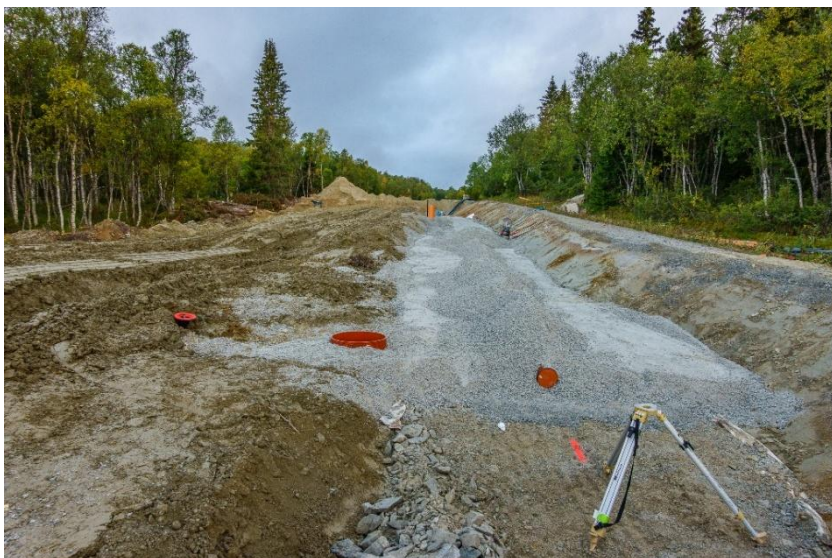
Bild tagen 2026-09-06. Återuppbyggnad av vägkropp pågår. Ny avloppsrensningsbrunn och vattenavstängning i mitten och till vänster i bild. Foto: Börjes Kalle Skarefjäll.
